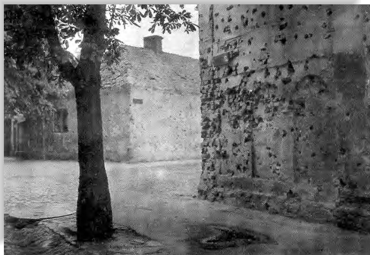
46. Zniszczone w trakcie walk domy na ul. Gimnazjalnej i Teatralnej (fot. Jan Buhak, „Tygodnik Ilustrowany” 1920, nr 39)
