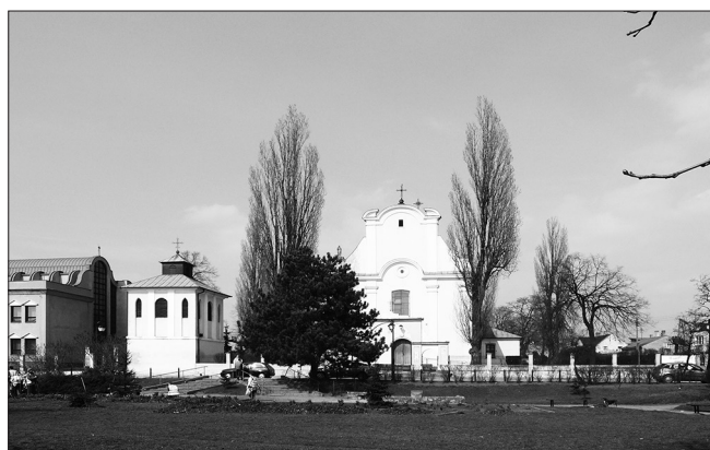
Fot. 1 i 2. Widok kościoła św. Piotra i Pawła w Żychlinie i dzwonnicy z przylegającym budynkiem jatek z około 1927 r. (źródło: archiwum Muzeum Regionalnego w Kutnie) oraz współczesny z 2009 r. (fot. B. Popławski).
