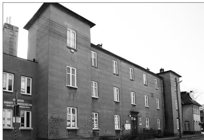
Budynek dawnego szpitala św. Mikołaja w Łęczycy. Stan z 2018 r. Fot. J. B. Nyczek
