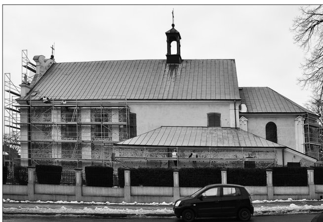
Fot. 8. Elewacja wschodnia kościoła z zewnętrznymi pilastrami, dobudowanym frontem, prezbiterium i kaplicą św. Walentego ze skarbcem podczas prac remontowych. Fot. Łukasz Kałębasiak
