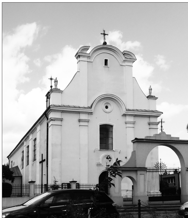
Fot. 1. Widok elewacji kościoła św. Piotra i Pawła w Żychlinie od strony południowej przed trwającymi obecnie pracami remontowymi. Fot. Bogdan Popławski
