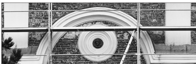
Fot. 7. Górny i środkowy fragment muru fasady z falistymi gzymsami (wieńczącym i kordonowym). Widoczny zróżnicowany układ warstw cegieł w licu muru – częściowo blokowy i wyłącznie główkowy oraz prawdopodobnie otwory wentylacyjne poddasza (obecnie zaślepione). Fot. Łukasz Kałębasiak
