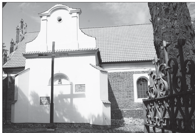
Fot. 5. Bożewo, kościół parafialny św. Andrzeja, kaplica grobowa Borzewskich, widok od południa (fot. Tomasz Kowalski, 2010 r.)
