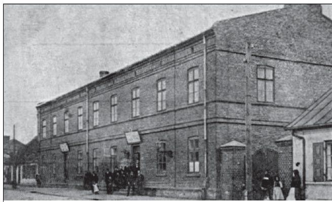
Rys. 8. Budynek dawnego dominium przy ul. Poznańskiej (ob. 1 Maja 25) przebudowany w 1898 r. dla Urzędu Gminy idwóch szkół elementarnych dla dziewcząt i chłopców. Fot. z lat 20.XX wieku przed nadbudową drugiego piętra. Fot. zbiory archiwalne Miejsko-Gminnej Biblioteki Publicznej w Żychlinie
