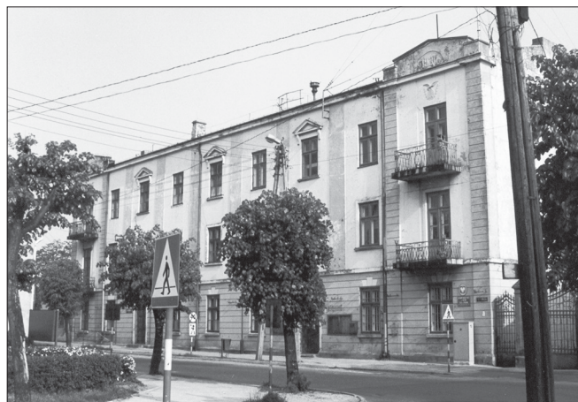
Rys. 11. Budynek dawnej Szkoły Powszechnej nr 1, magistratu i lokalu policji po nadbudowie drugiego piętra w 1930 r. Fot. Autora z 2010 r.
