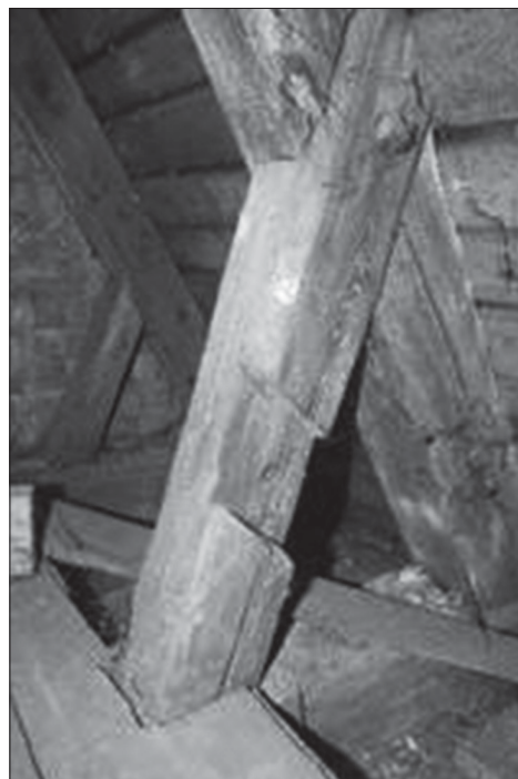
Witornie użyty element średniowiecznej konstrukcji dachowej z widocznymi gniazdami dawnych połączeń ciesielskich. Fot. M. Warchoń
