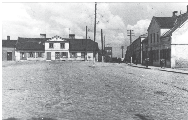
Rys. 7. Budynek mieszkalny wschodniego fragmentu północnej pierzei d. Nowego Rynku, ob. Pl. Jana Pawła II nr 4 – widok od strony placu z lat 30.XX wieku. Fot. zbiory archiwalne Miejsko-Gminnej Biblioteki Publicznej w Żychlinie
