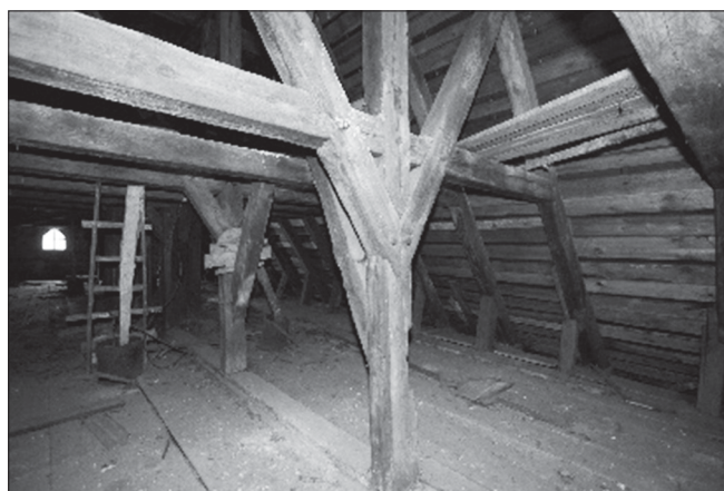
Widok konstrukcji dachowej nad prezbiterium kościoła. Fot. M. Warchoń
