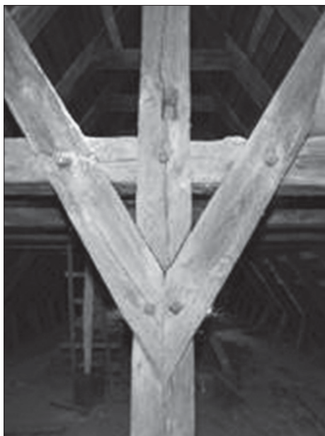
Połączenia ciesielskie elementów w wiązarze pełnym konstrukcji. Fot. M. Warchoń
