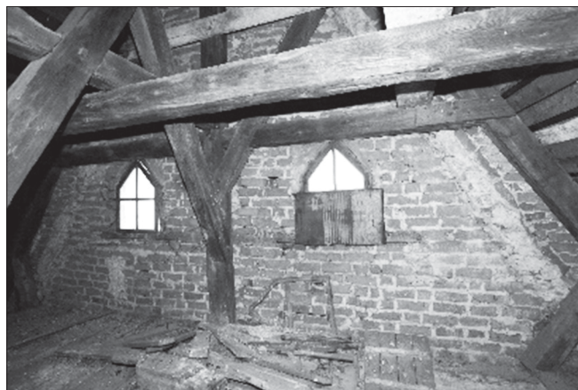
Widok wiażara szczytowego konstrukcji dachowej nad nawą kościoła. Fot. M. Warchoń
