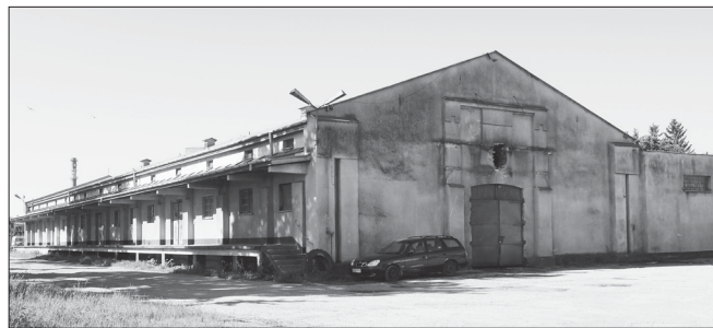
Pomieszczenia dawnej fabryki „Sierpczanka”. Zdjęcie z czerwca 2019 r.
