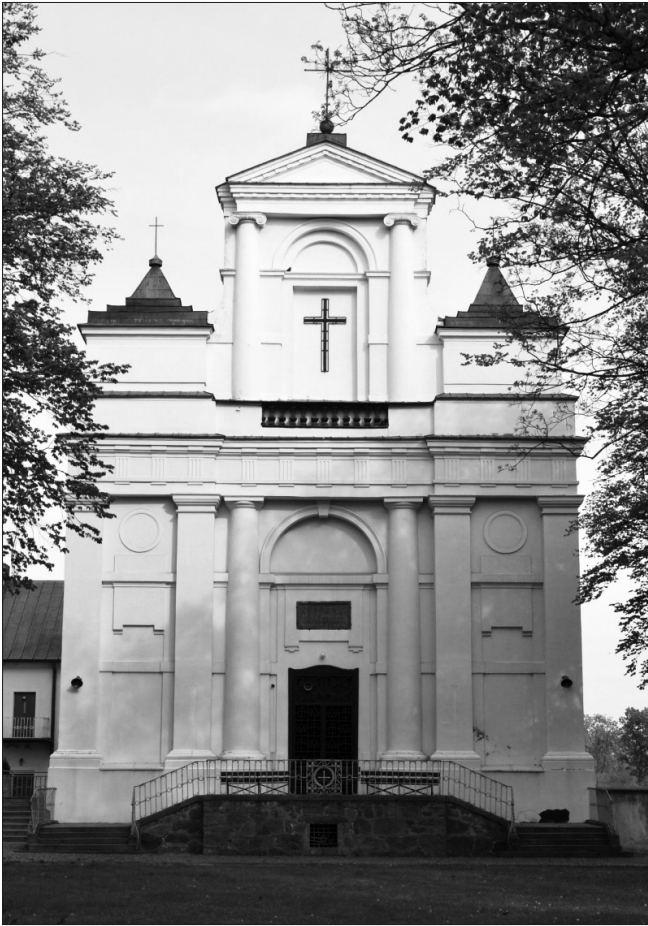
Kościół parafialny w Szczawinie Kościelnym Fot. G. Gołębiewski
