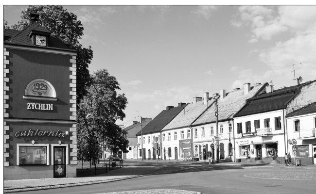
Z lewej dawna wieża transformatorowa przy Pl. 29 Listopada Fot. Grzegorz Gołębiowski, 2020 r.
