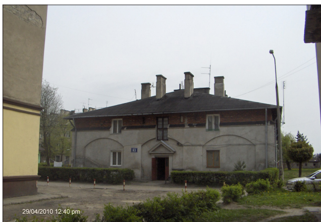
Fot. 11. Budynek mieszkalny pracowników fabryki z końca lat 60. XIX wieku (dawna stodoła folwarku Budzyń, ob. ul. Narutowicza 83). Widok od strony ulicy (zachodniej). Zdjęcie autora 2010
