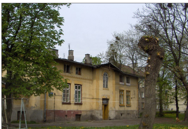
Fot. 9 i 10. Budynek dawnego szpitala przyfabrycznego wzniesiony w 1881 r. (ob. ul. Narutowicza 81). Widok od strony ulicy (zachodniej) i od podwórza (wschodniej). Zdjęcie autora 2010
