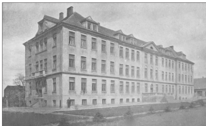
Budynek Szpitala powiatowego pw. św. Antoniego (strona pód. zach.)
