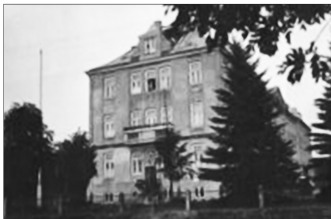
Elewacja szpitala od strony zachodniej
