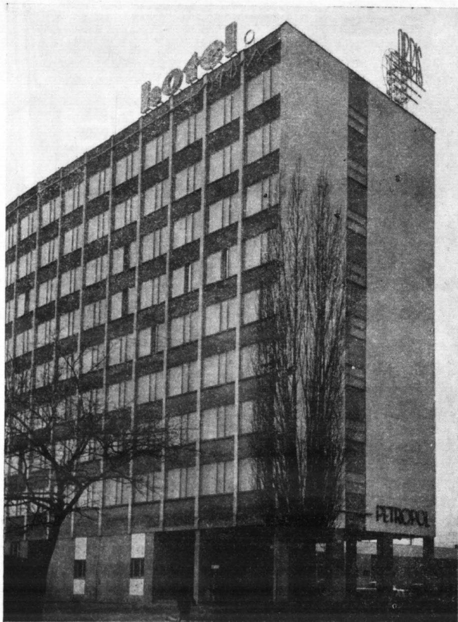
Hotel kat. S „Orbis-Petropol” o 172 łózkach z restauracją (130 miejsc) i kawiarnią (90 miejsc) wybudowany przez Mazowieckie Zakłady Rafineryjne i Petrochemiczne — jako inwestycja towarzysząca.
