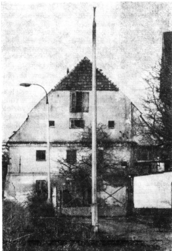
Zabytkowy spichlerz na skraju osuwiska. Widoczna rysa pęknięcia murów.
