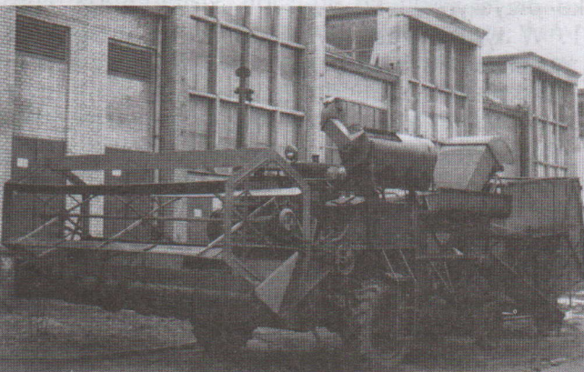
Kombajn ŻMS-4 po modernizacji, w wersji z chwytaczem plew w końcowej fazie produkcji
