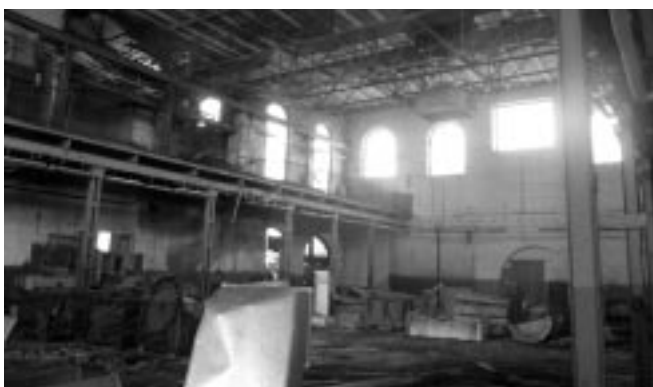
Fot. 4. Główna hala produkcyjna d. cukrowni z lat 70. XIX wieku, przebudowana w 1922 r. – nie użytkowane i zdewastowane wewnątrz. Foto autora 2010 r.
