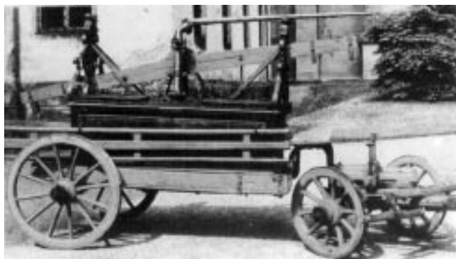
Rys. 3. Sikawka czterokołowa z górną skrzynią wodną, z dwuramienną dźwignią do pompowania (1809 r.) 8
