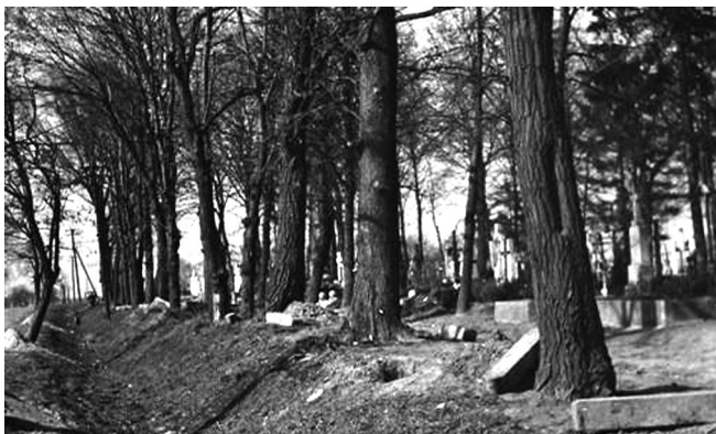
Prace przy grodzieniu cmentarza w Trzepowie w 1965 r. 46
