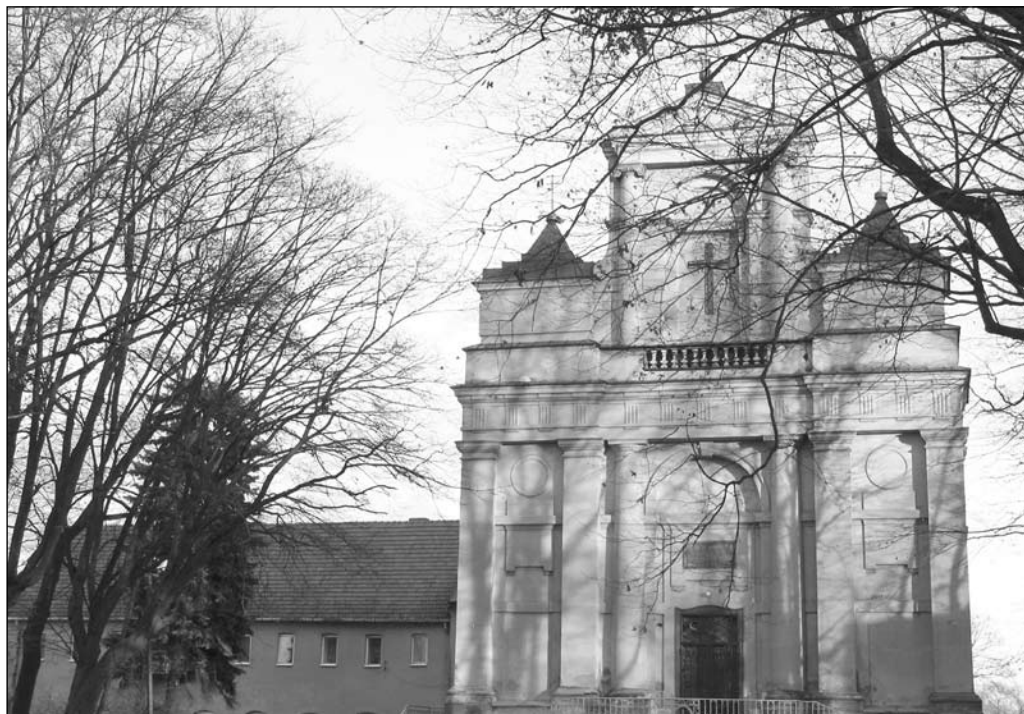
Kościół pw. Nawiedzenia Najświętszej Marii Panny w Szczawinie Kościelnym wraz z fragmentem zachowanego skrzydła klasztoru franciszkanów-reformatów. Fot. J. Domagała
