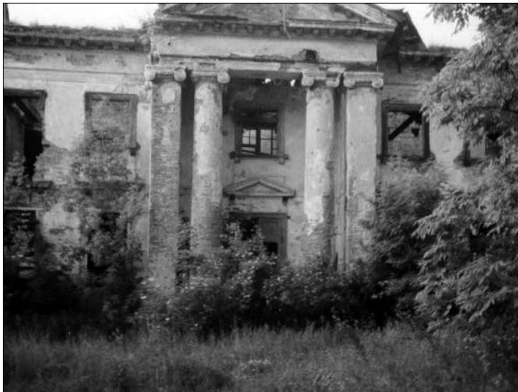
Ruiny pałacu w Studzieńcu. Stan z 2007 r. Fot. Małgorzata Chudzyńska
