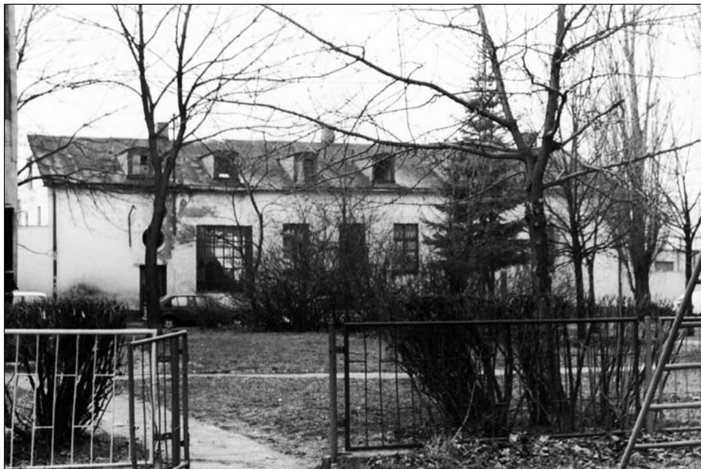
Mykwa w Gostyninie, po II wojnie światowej budynek mleczarni przy obecnej ulicy S. Wyszyńskiego. Stan z 1990 r. przed rozbiórką. Fot. Daria Błaszczuk
