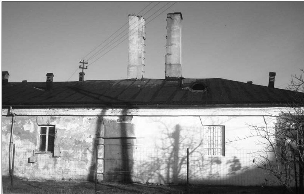
Budynek dawnej łaźni przy ulicy Bagnistej w Gostyninie. Stan z 2008 r. Fot. Barbara Konarska-Pabiniak
