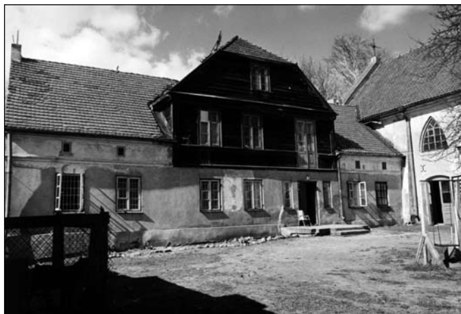
Drewniana pastorówka w pierwszej fazie rozbiórki w 2002 r. Fot. Benedykt Józkowiak
