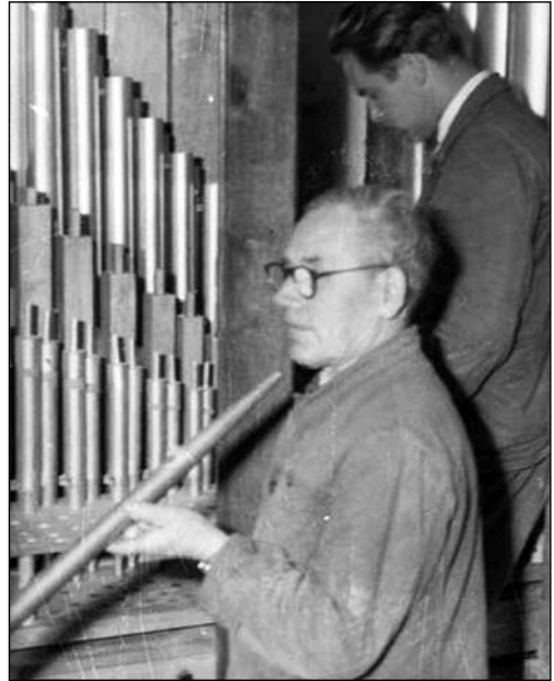
Pracownicy firmy K. Majszczuk i B. Pulsza w trakcie budowy organów w Trębkach w 1958 r. Fot. z kroniki parafialnej z lat 1945–1963
