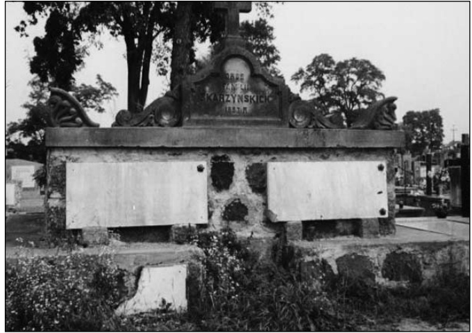
Grobowiec rodziny Skarzyńskich na cmentarzu w Słubicach, wzniesiony w 1893 r. Fot. Marian Chudzyński
