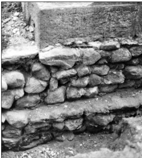
Ryc. 12. Gostynin. Badania w 1983 r. – sondaż 01 z fundamentem zachodniego muru obwodowego (faza II). Widok od zachodu
