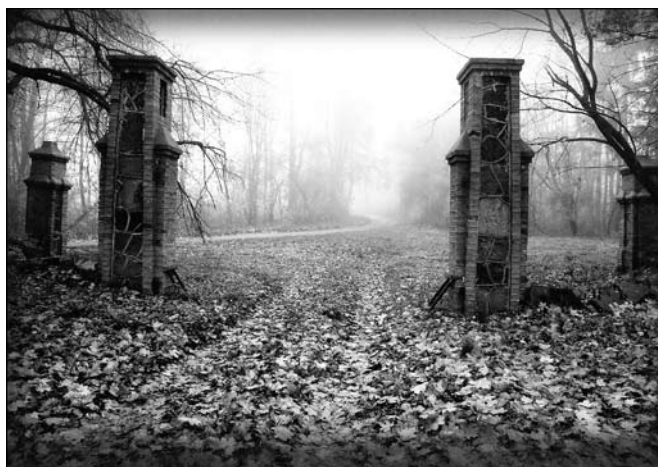
Brama wjazdowa. Stan z 8 XI 2008 r. Fot. M. Konarski
