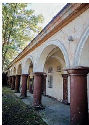
Jatki miejskie, widok od północy. Fot. T. Topczewski
