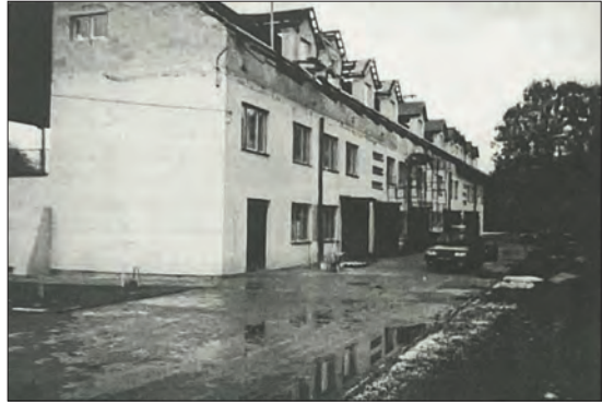
Remont kapitalny budynku głównego na stadionie, stan na sierpień 1998 r. Źródło: „Głos Gostyniński” 1998, nr 14, s. 6
