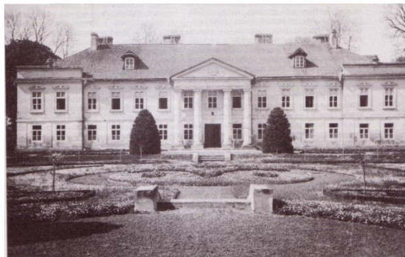
43. Poryck. Elewacja frontowa pałacu „lewego”. Stan z 1938 r.
