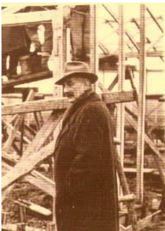
305. Zdzisław Antoni (266) Karnkowski. Lata „doj- rzałe“, przy budowie szklarni.
