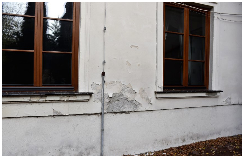
W 2024 r. przeprowadzono prace naprawcze oraz malowanie elewacji od strony ogrodu w budynku przy pl. Narutowicza 8. Stan przed (zdjęcie górne) i po remoncie (zdjęcie dolne)
