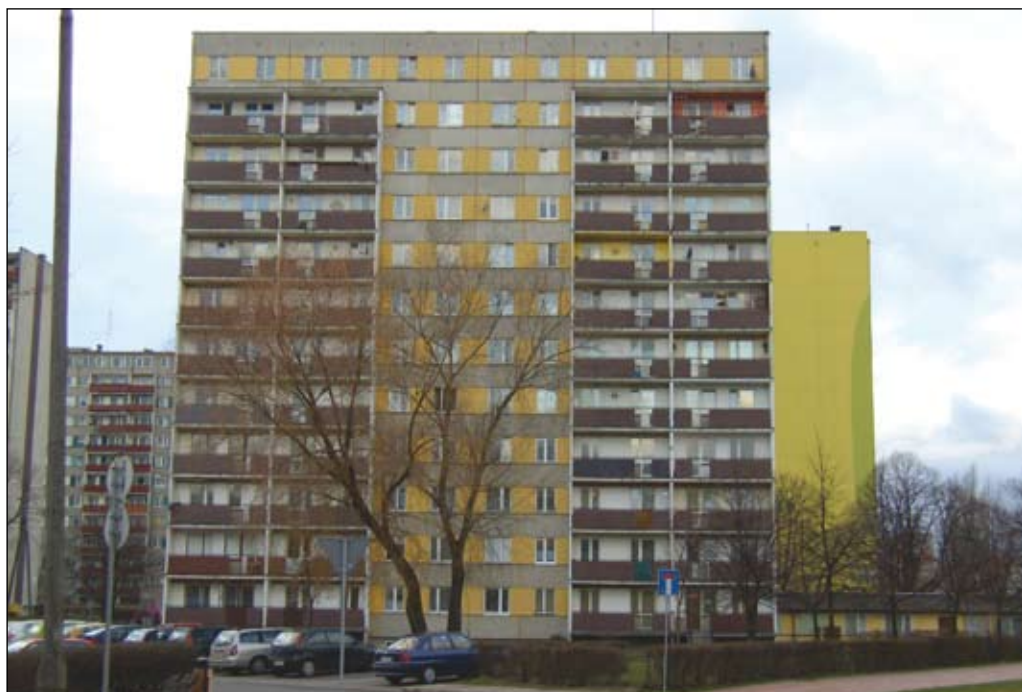
Fot. 132. Wieżowiec przed termomodernizacją przy ul. Dworcowej
