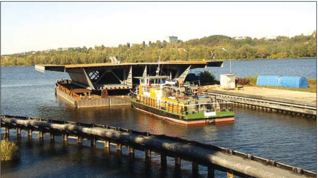
Fot. 51. Transport Wisłą przęseł mostu
