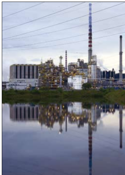
Fot. 75. Kominy elektrociepłowni
