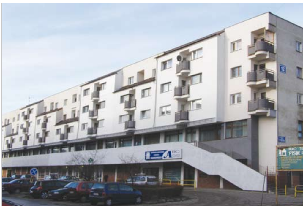
Fot. 142. Budynek mieszkalno-handlowy przy ul. 3 Maja
