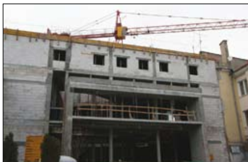
Fot. 65. Budowa kina Nove Przedwiośnie
