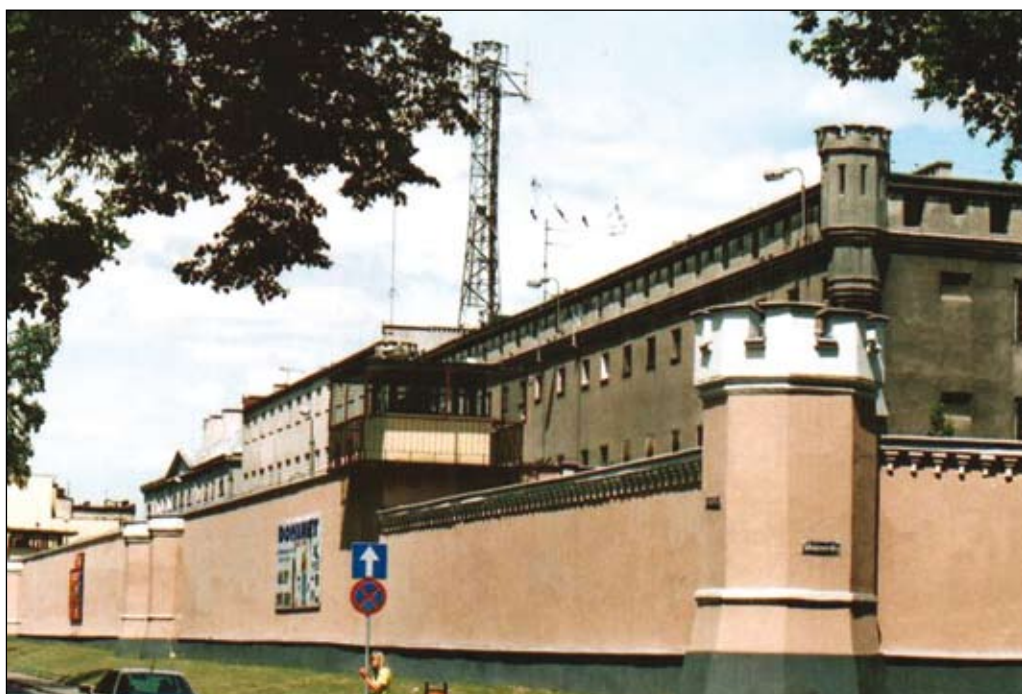
Fot. 20. Klasycystyczny budynek starego więzienia przy ul. H. Sienkiewicza
