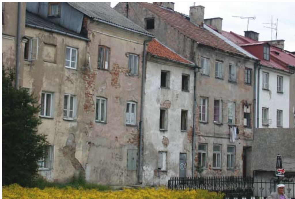
Fot. 21. Południowa pierzeja zespołu kamienic przy ul. J. Kwiatka od placu Trzynastu Straconych
