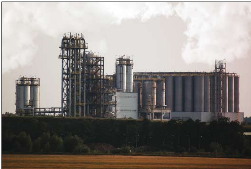
Fot. 77. Instalacje Basell Polyolefins
