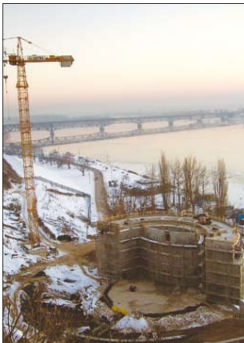
Fot. 58. Amfiteatr płocki. Budowa zaplecza sceny
