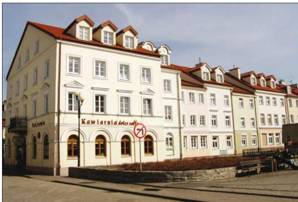
Fot. 24. Dom Rabina przy ul. J. Kwiatka po renowacji
