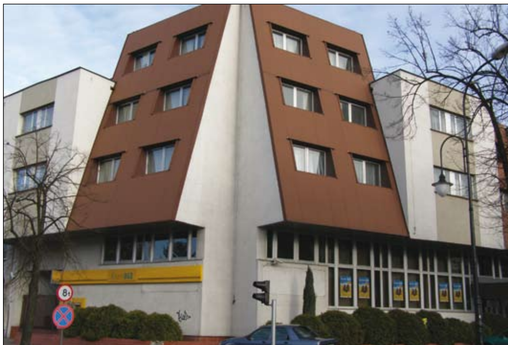
Fot. 98. Obiekt oddziału w Płocku Banku Gospodarki Żywnościowej, róg ul. 1 Maja i Królewieckiej
