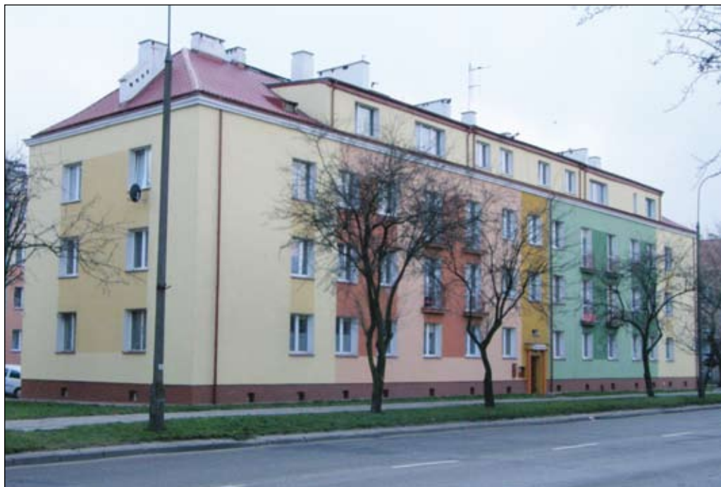
Fot. 120. Budynki mieszkalne z lat 50 XX w. przy ul. A. Mickiewicza
