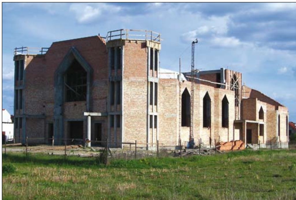
Fot. 36. Kościół pw. św. Wojciecha na Podolszycach Południu w budowie
