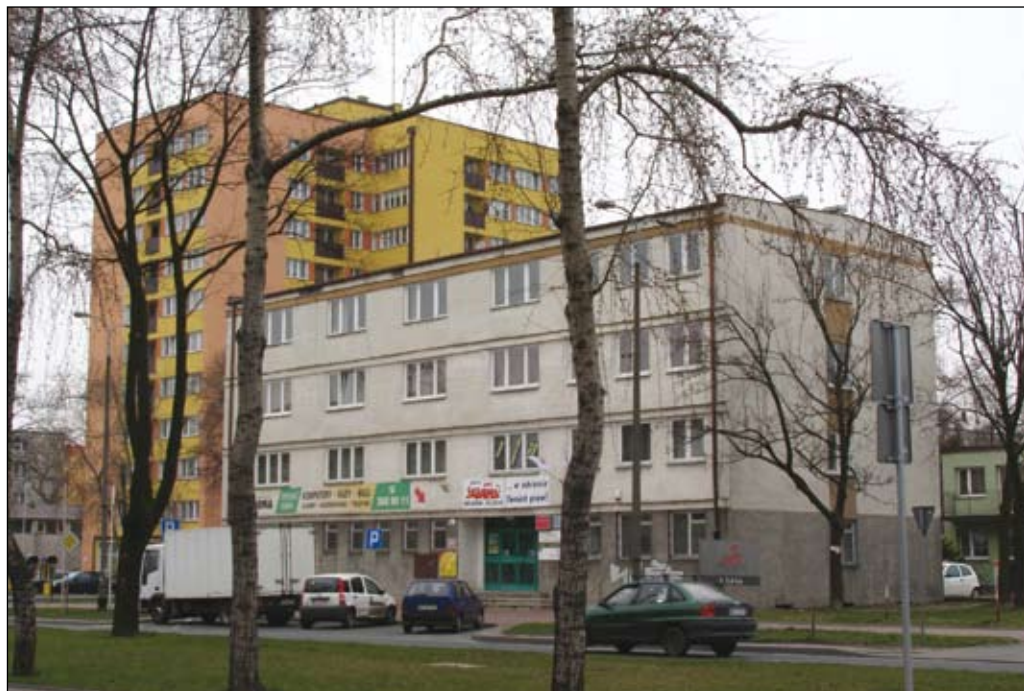
Fot. 99. Gmach Biura Planowania Przestrzennego i siedziba NSZZ Solidarność przy Al. S. Jachowicza
