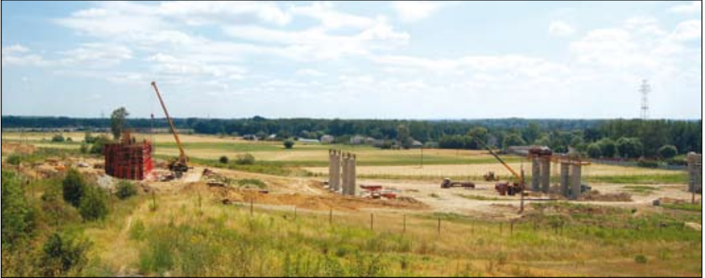
Fot. 48. Tereny zalewowe nad Wisłą. Pierwsze podpory nowego mostu
