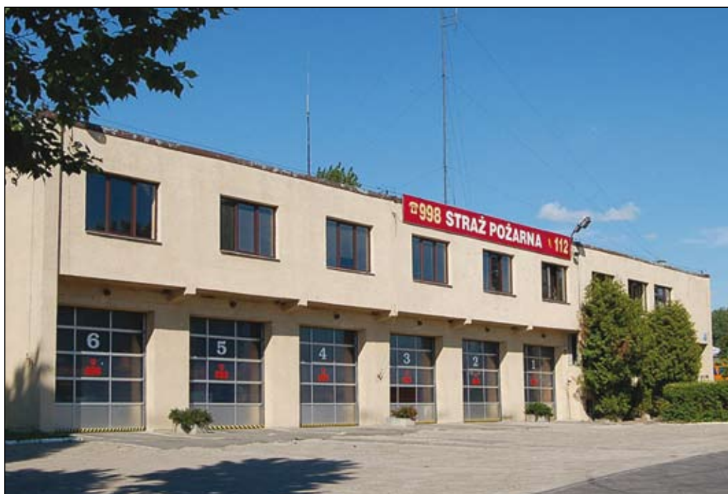
Fot. 96. Budynek Zawodowej Straży Pożarnej przy ulicy Przemysłowej
