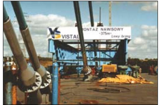
Fot. 50. Mocowanie odciągów pylonów
