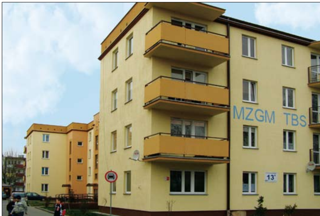
Fot. 118. Nowe budynki MZGM-TBS przy ul. J. Kochanowskiego
