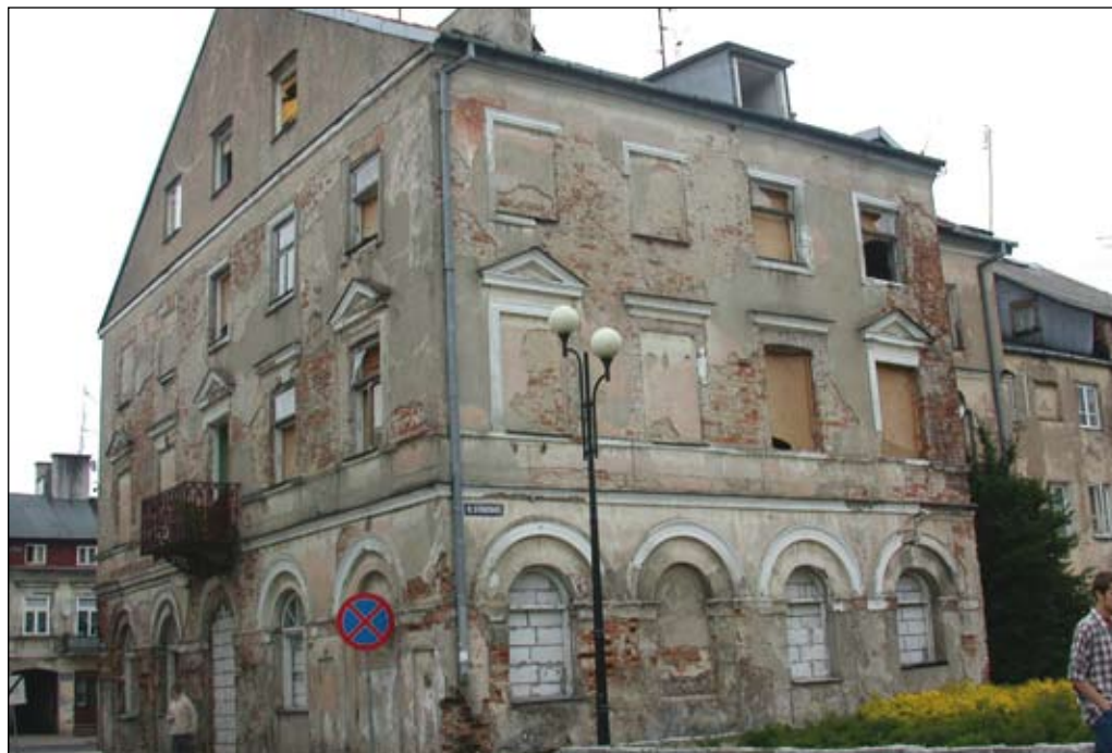
Fot. 23. Dom Rabina przy ul. J. Kwiatka przed renowacją
