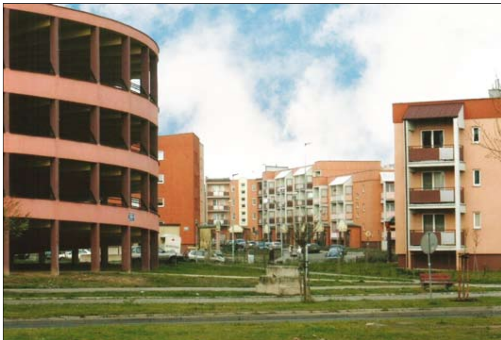
Fot. 147. Osiedla MTBS w dzielnicy Podolszyce Południe
