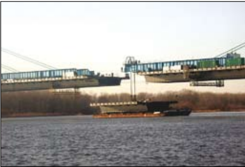
Fot. 49. Moment połączenia obu przęseł mostu
