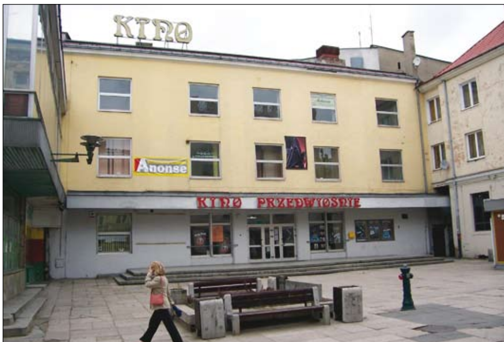
Fot. 66. Kino Przedwiośnie przed rozbiórką
