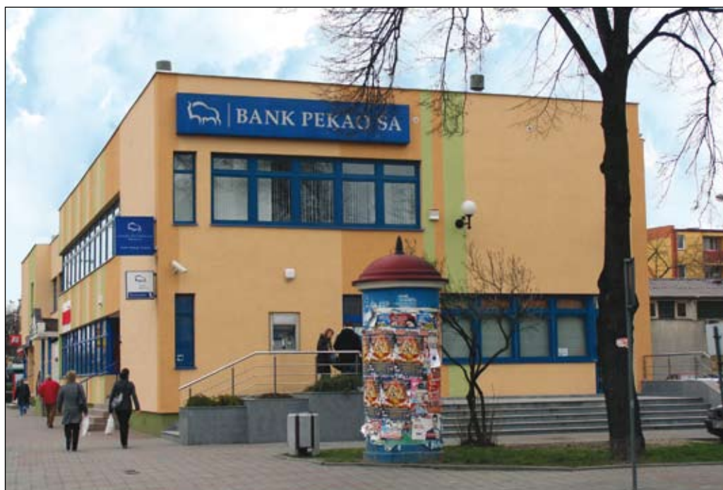
Fot. 100. Siedziba oddziału Banku PKO SA przy Al. S. Jachowicza
