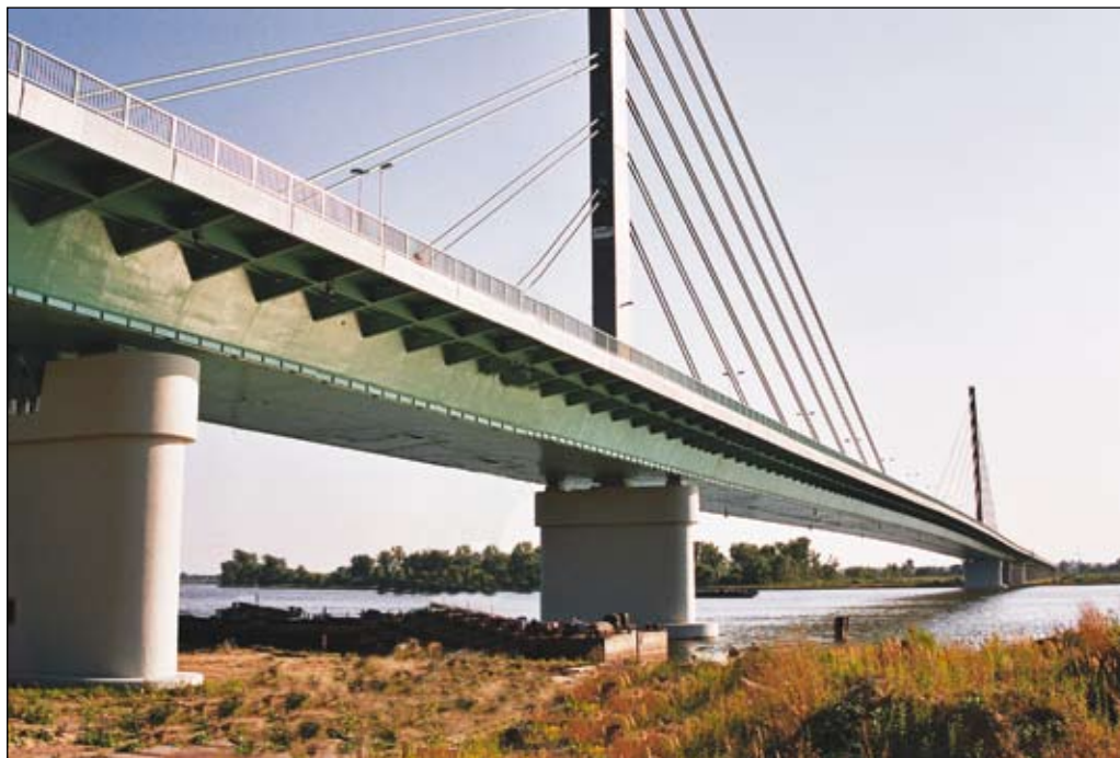
Fot. 52. Most im. Solidarności — widok na betonowe podpory z prawego brzegu rzeki
