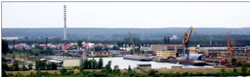
Fot. 45. Widok ze skarpy wiślanej na przemysłową część Radziwiewa
