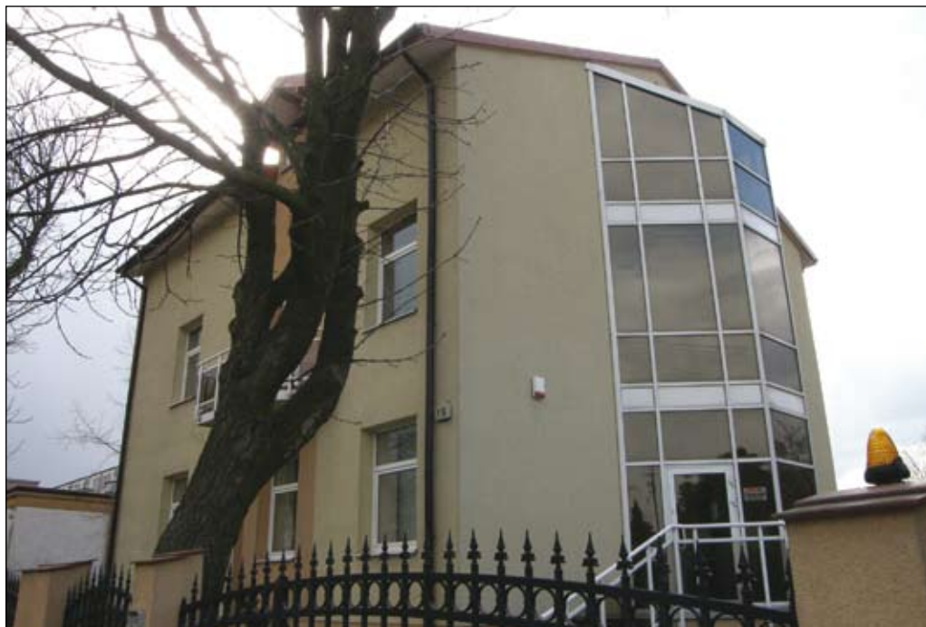
Fot. 139. Budynek biurowy przy ul. Dworcowej
