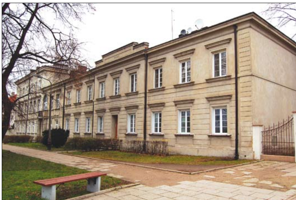
Fot. 18. Obiekty Seminarium Duchownego przy pl. E. Jurgensa
