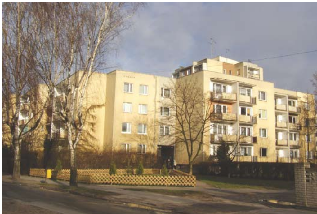
Fot. 143. Budynki mieszkalne przy ul. 3 Maja
