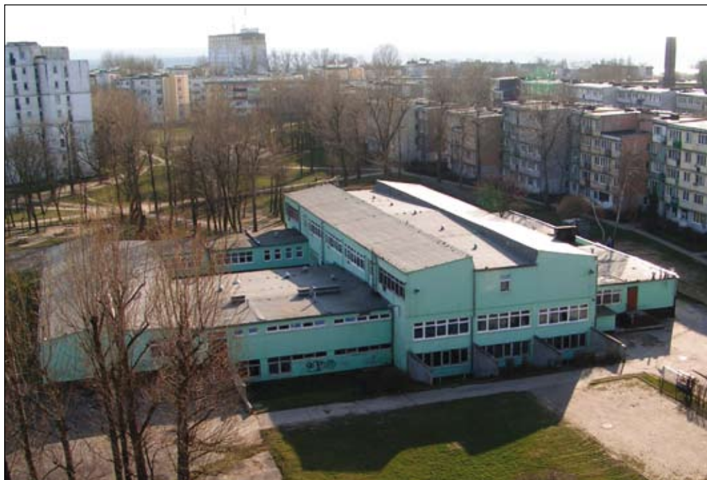
Fot. 112. Szkoła Podstawowa nr 17 przy ul. Miodowej
