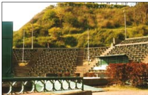
Fot. 56. Amfiteatr płocki przed przebudową
