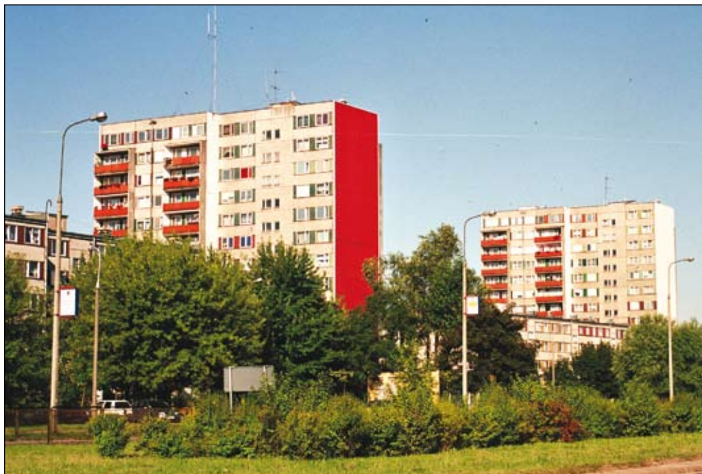
Fot. 153. Wieżowce osiedla Międzytorze przy ul. J. Piłsudskiego
