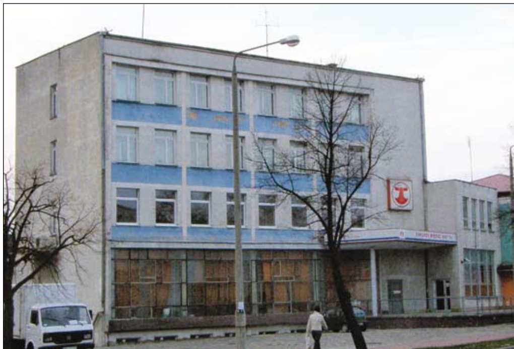
Fot. 110. Budynek biurowy byłych Zakładów Mięsnych Płock przy ul. Bielskiej
