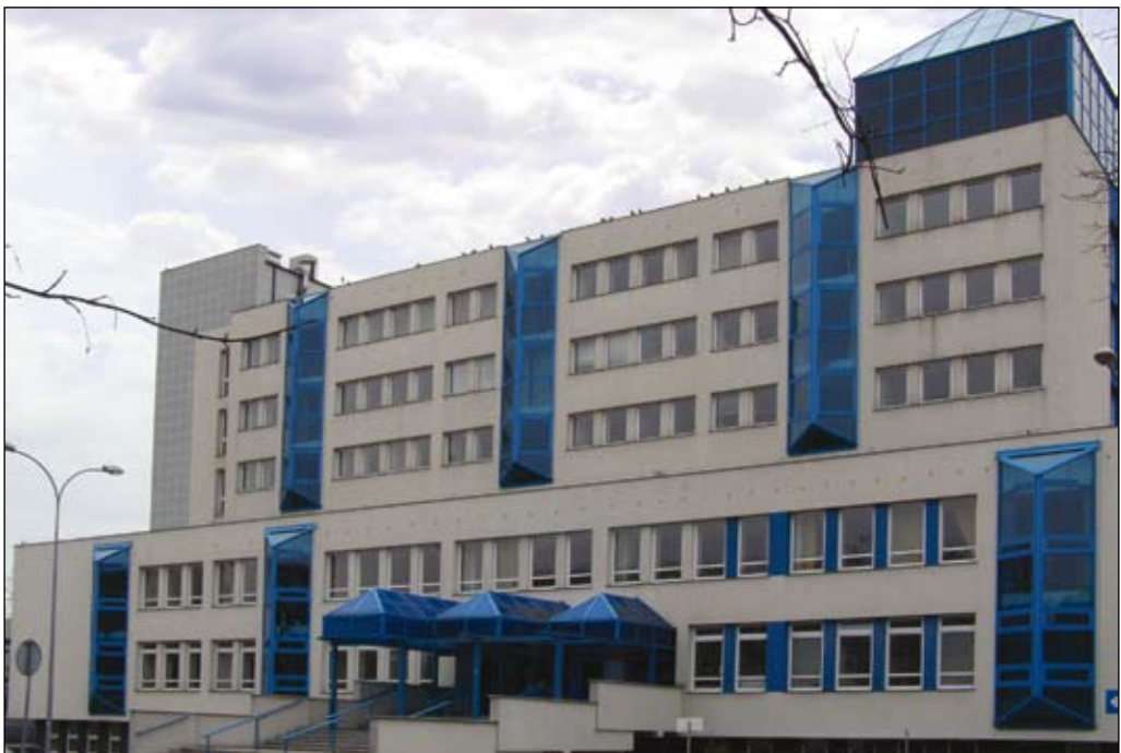
Fot. 84. Elewacja frontowa budynku Urzędu Skarbowego w Płocku
