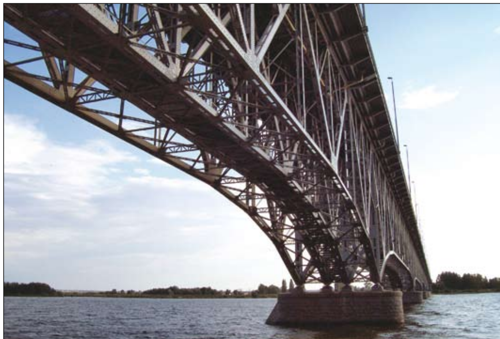
Fot. 54. Most kolejowo-drogowy im. Legionów Marszałka Józefa Piłsudskiego
