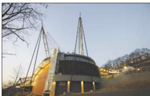
Fot. 57. Modernizacja amfiteatru. Montaż pylonów
